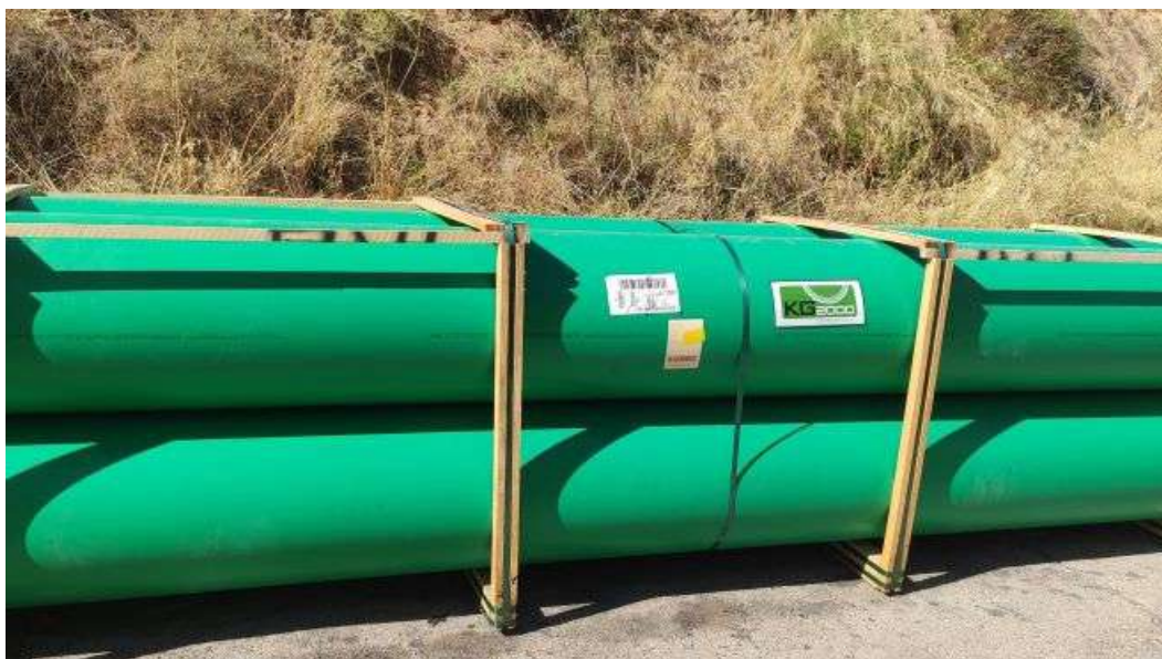
FOTO: D.H. / La nova canonada que s'instal·larà al carrer Reial dels Mangraners, d'origen alemany i material reciclat
