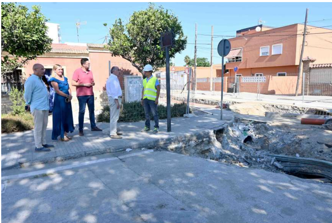
VISITA OBRAS RINCONCILLO
