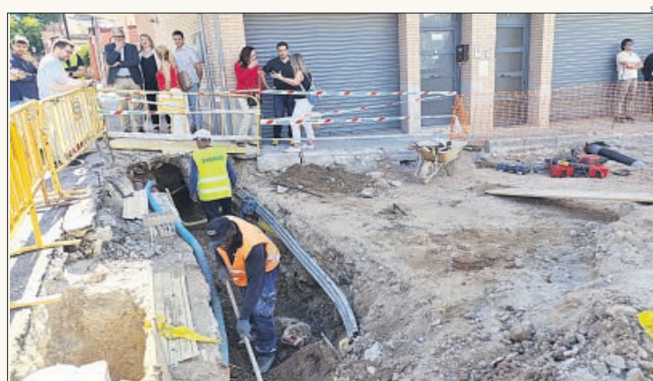
Operarios trabajando ayer en la renovación de la red de agua y alcantarillado de la calle Reial.
