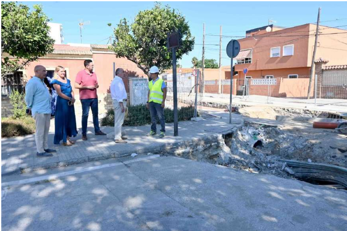
Landaluce afirma que las obras en la avenida Diputación acabarán con las inundaciones en El Rinconcillo.
